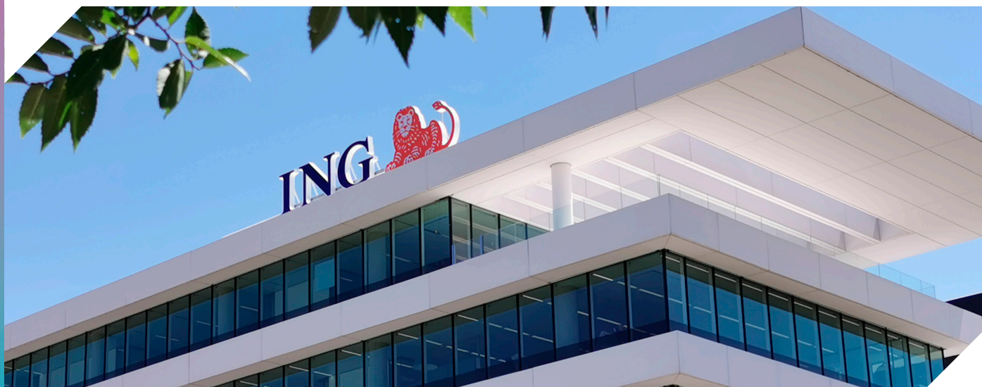
△ Detalle de la fachada del edificio de oficinas de ING.
